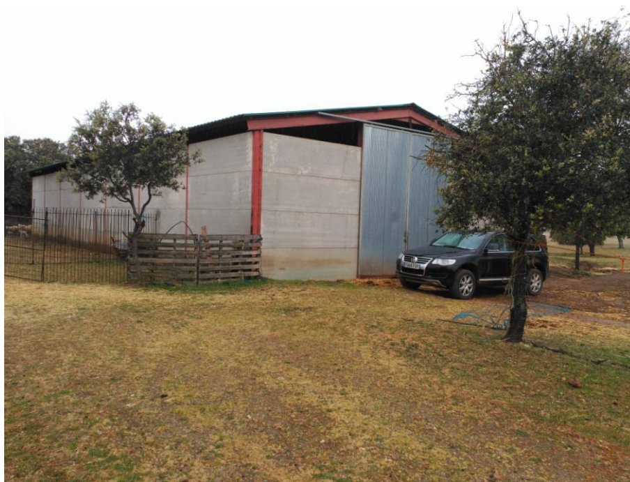
Imagen 1: Detalle de la nave de cebo desde el astial norte y el lateral este; detalle de las paredes de placa alveolar; la nave es a dos aguas, con estructura metálica y cubierta de chapa prelacada verde 0,6 mm.
