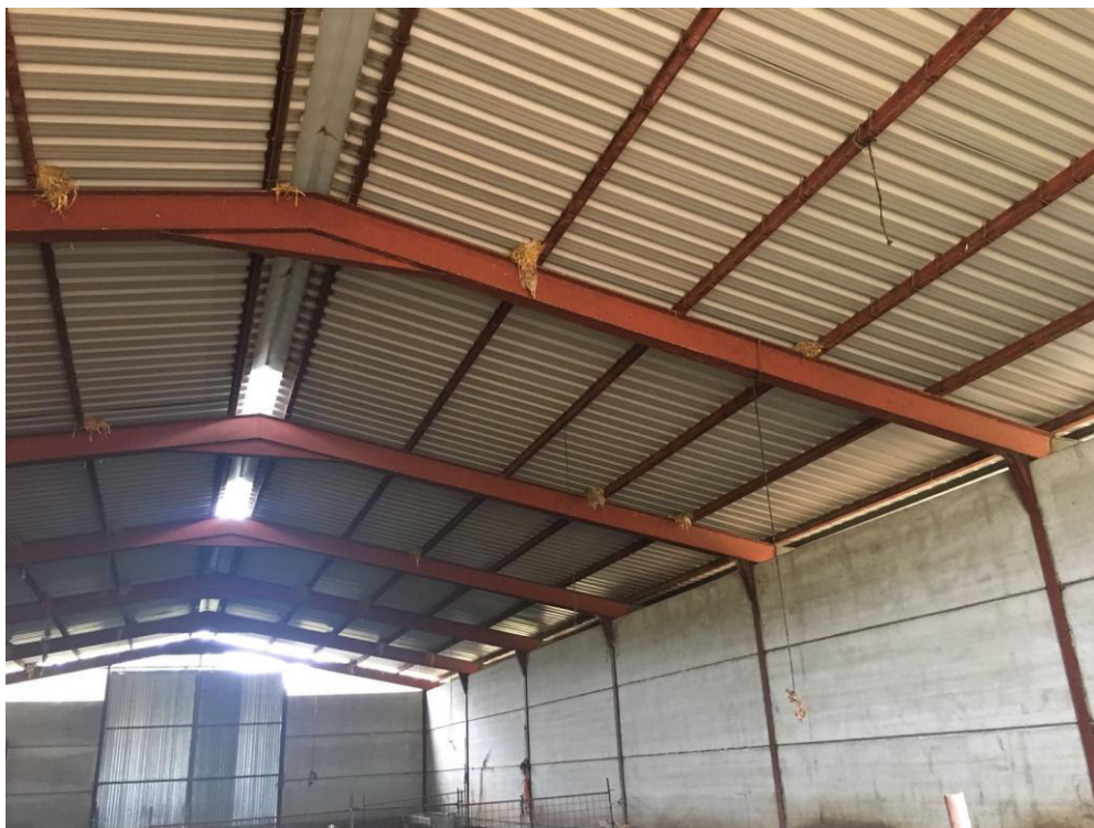
Imagen 4: Detalle de la estructura, acartelamientos y cubierta, con pilares IPE-180, pórticos IPE-270, y correas IPE-100. Se aprecia el cerramiento de toda la nave de cebo mediante placa alveolar de 14 ,5 cm. También apreciamos varios aireadores en la cumbre.
