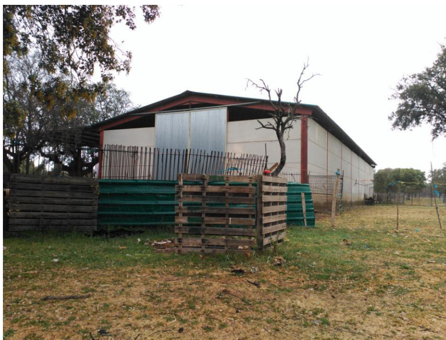
Imagen 2: Detalle de la parte posterior del cebadero, correspondiente con el astial sur y el lateral este; se aprecia el hueco corrido para darle iluminación y ventilación a la instalación cuando se encuentra con las puertas de los dos astiales cerradas.
