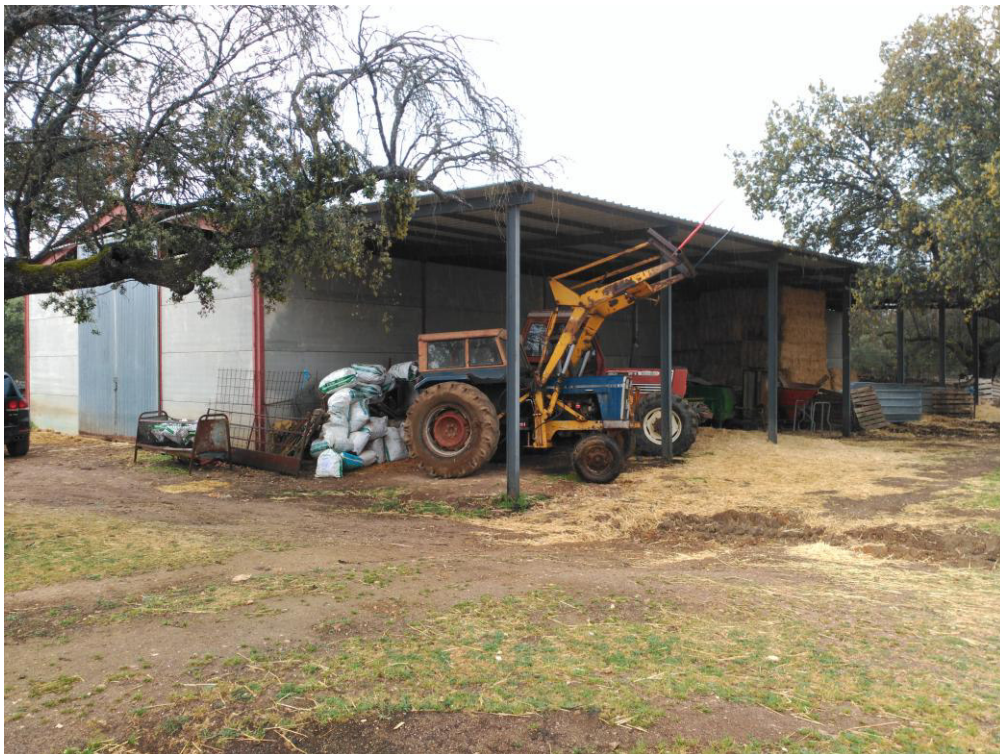
Imagen 3: Detalle de la tenada de cebo, utilizada en la actualidad como almacén de productos y maquinaria. Se aprecian los pilares, vigas y correas de la estructura metálica que posee. Las dos instalaciones poseen solera de tierra .
