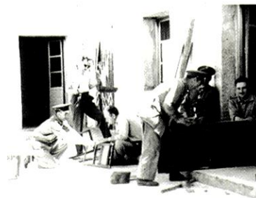
■ GUARDIAS REALIZANDO TAREAS DE REPARACIÓN EN EL PATIO DE LA CASA-CUARTIL Camporredondo (Villar de Ciervo)
