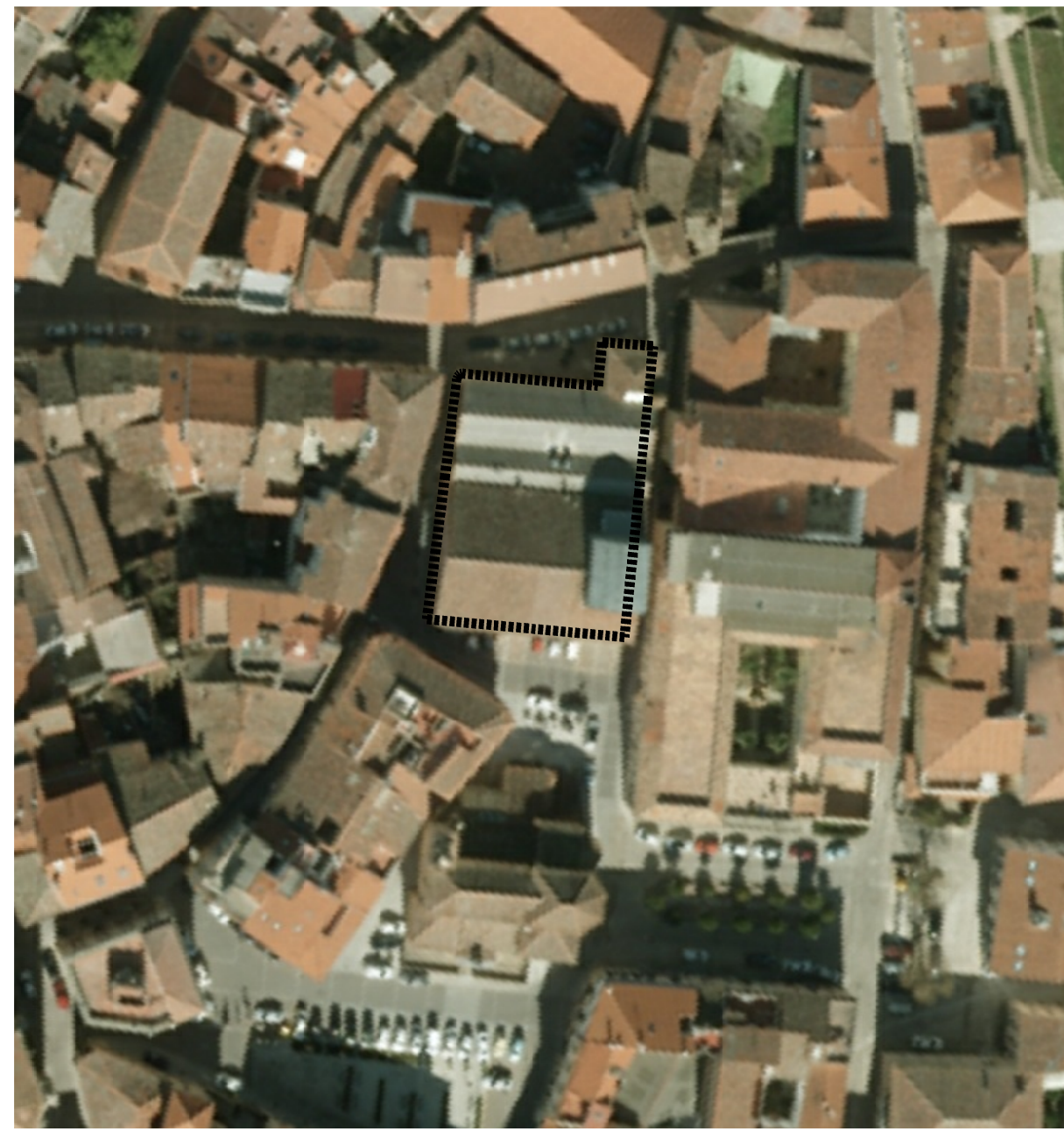
VISTA AEREA. MANZANA 171
